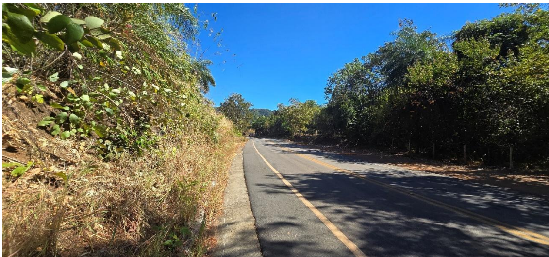
Foto 2 – Vegetação e talude do entorno da TO-030
